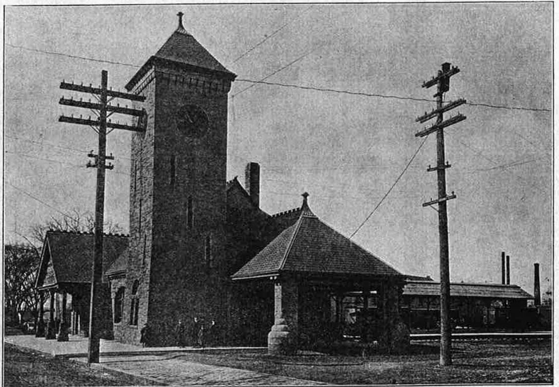
STATION OF THE N. Y., N. H. & H. R. R.
